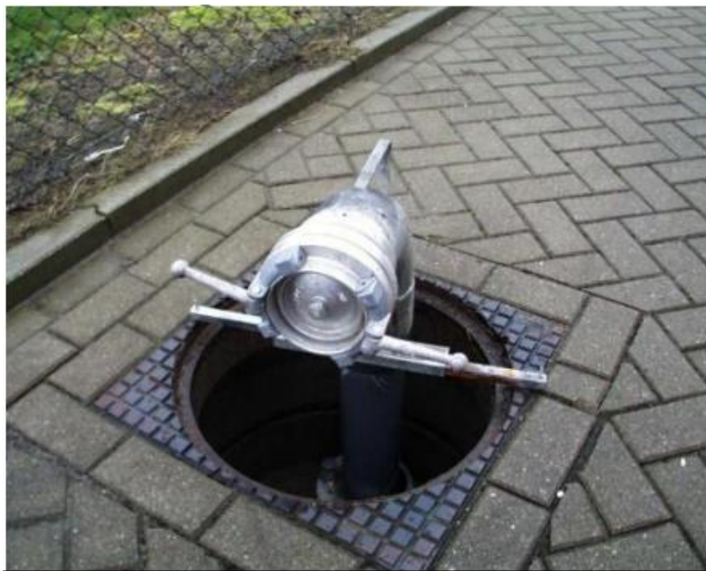
Voorbeeld geboorde put met flexibele inhanger.
