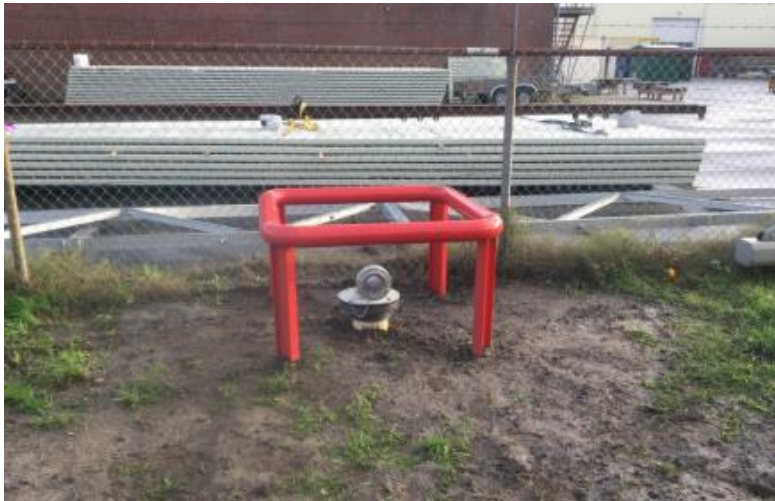
Voorbeeld geboorde put met vaste bovengrondse aansluiting.
